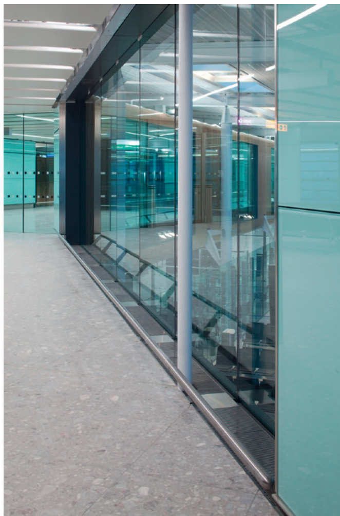
Flughafen Heathrow, London, Terminal Pier T2B North
