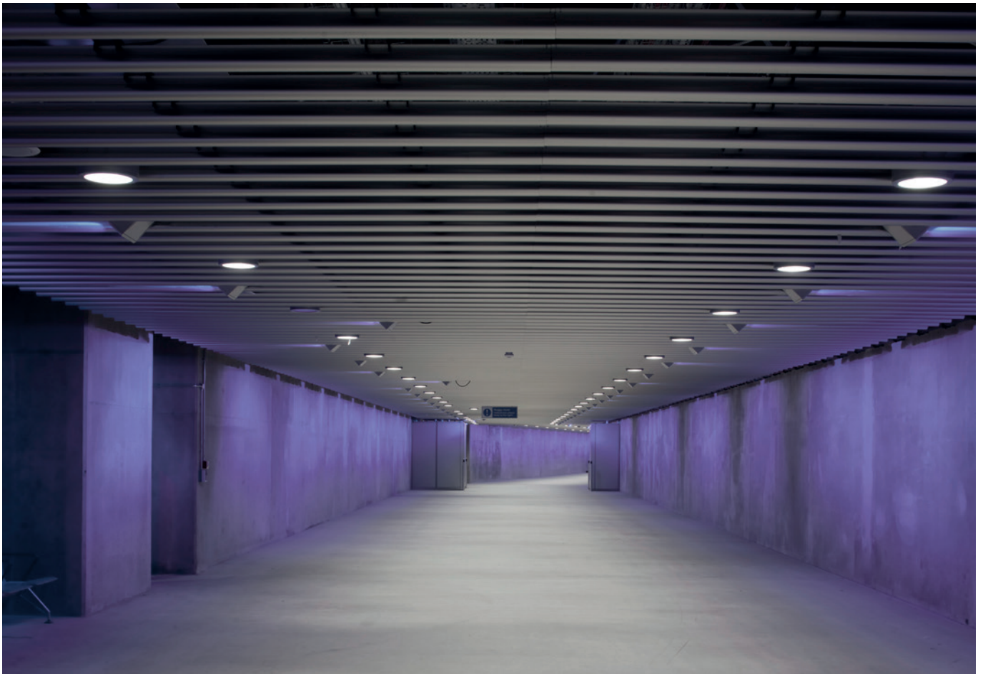
Flughafen London Heathrow, Terminal 5. Unterirdische Verbindungen zwischen den Flugsteigen A,B
