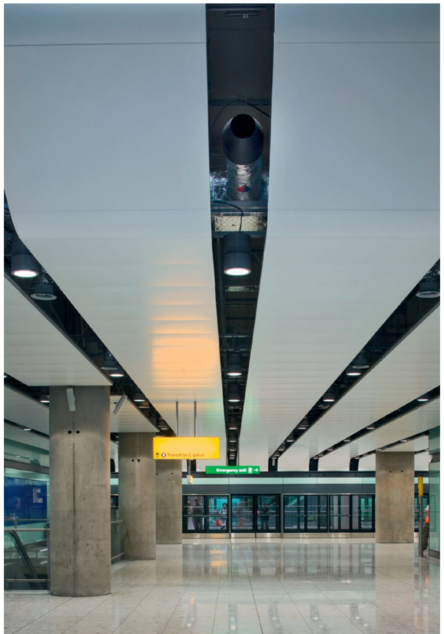
Flughafen Heathrow, London, Terminal 5 TTS Bereich
