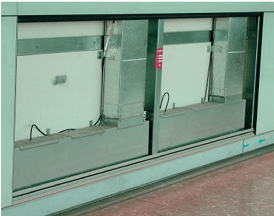
Flughafen Heathrow, London, Terminal T5A
