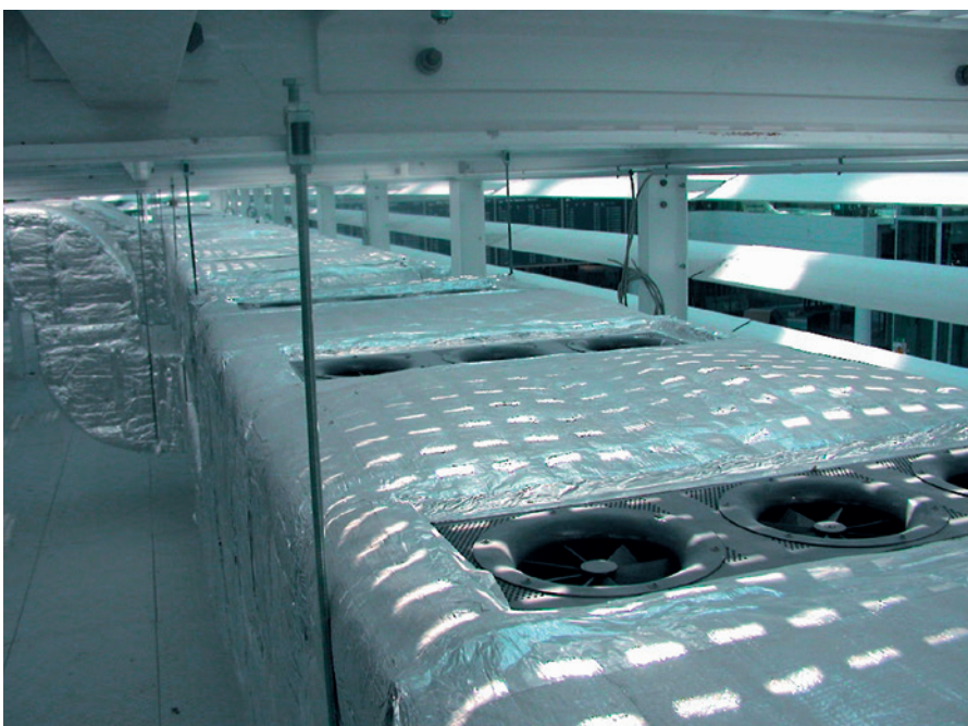
Installation von Mehrfachdralldurchlässen im oberen Bereich der Zuluft.
