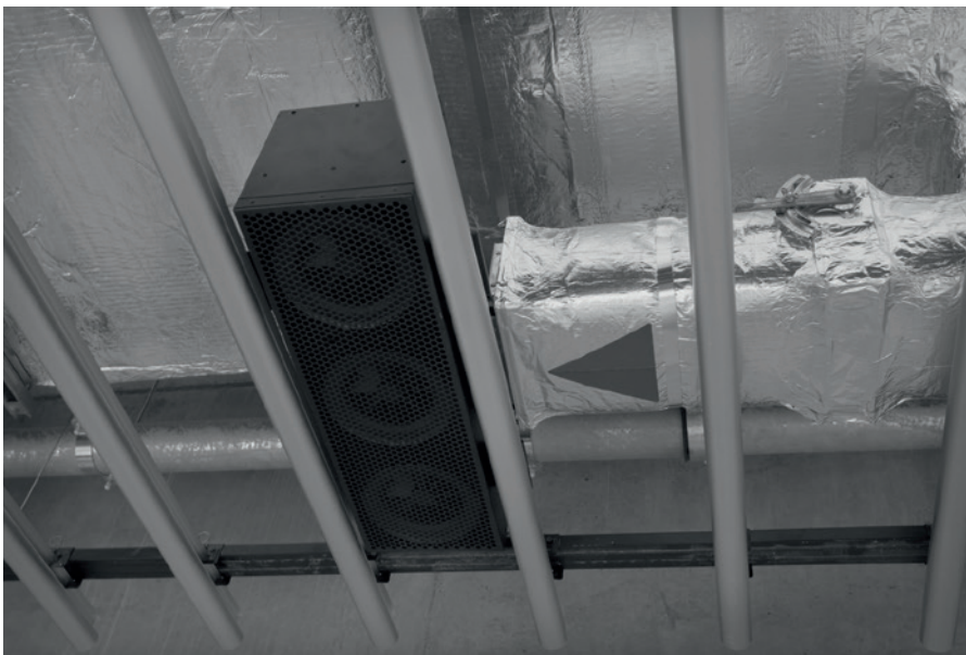
Nicht variabler Decken Zuluft- durchlass zum Heizen und Kühlen. Abmessung: 675 x 188 x 225 mm. Volumenstrom: 360 m 3 /h
